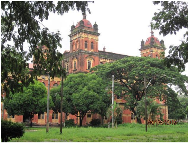
ヤンゴン旧市街地に点在する伝統建造物のひとつである旧植民地時代の旧ビルマ省庁舎
