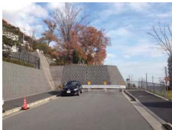
都市計画道路渦ヶ森線の未整備部分
