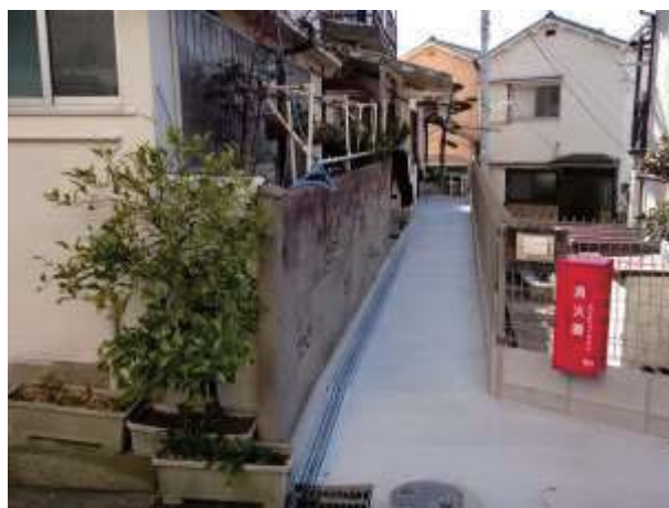
緊急避難サポート事業により安全な通路の整備（泉が丘北地区）
