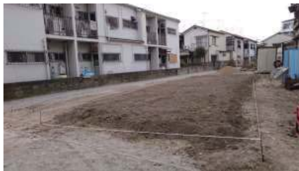
完成予定のまちなか防災空地（城が山北地区）
