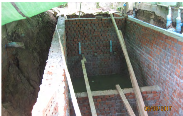
タンリン郡区市場の腐敗槽の増設工事
