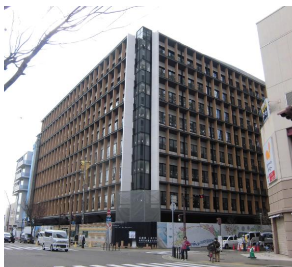
新長田合同庁舎（建築中）
