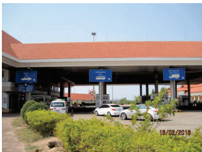
ラオス側出国管理ゲート
