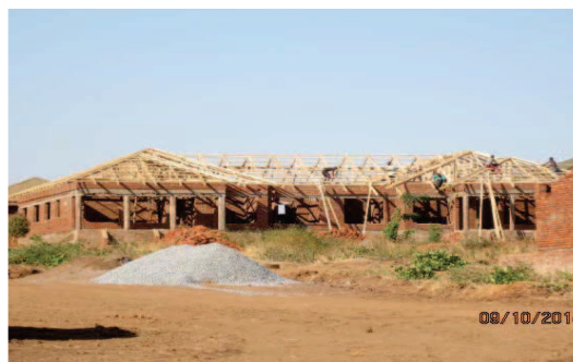
現状：道路や排水施設が未整備のまま住宅建設が進む
