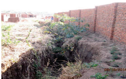
Layout Planに排水施設がないため、自然水路が拡張
