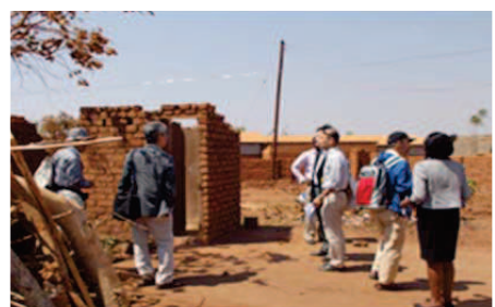
非計画区域の現場調査 （伝統的居住区THAの住宅建築現場）
