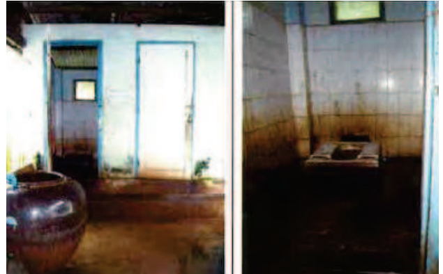
チャウタン郡区病院のトイレ
